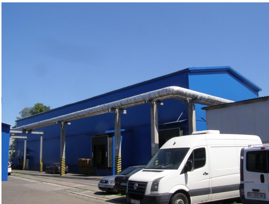
Рис. 6 – Вигляд будівлі після реконструкції
