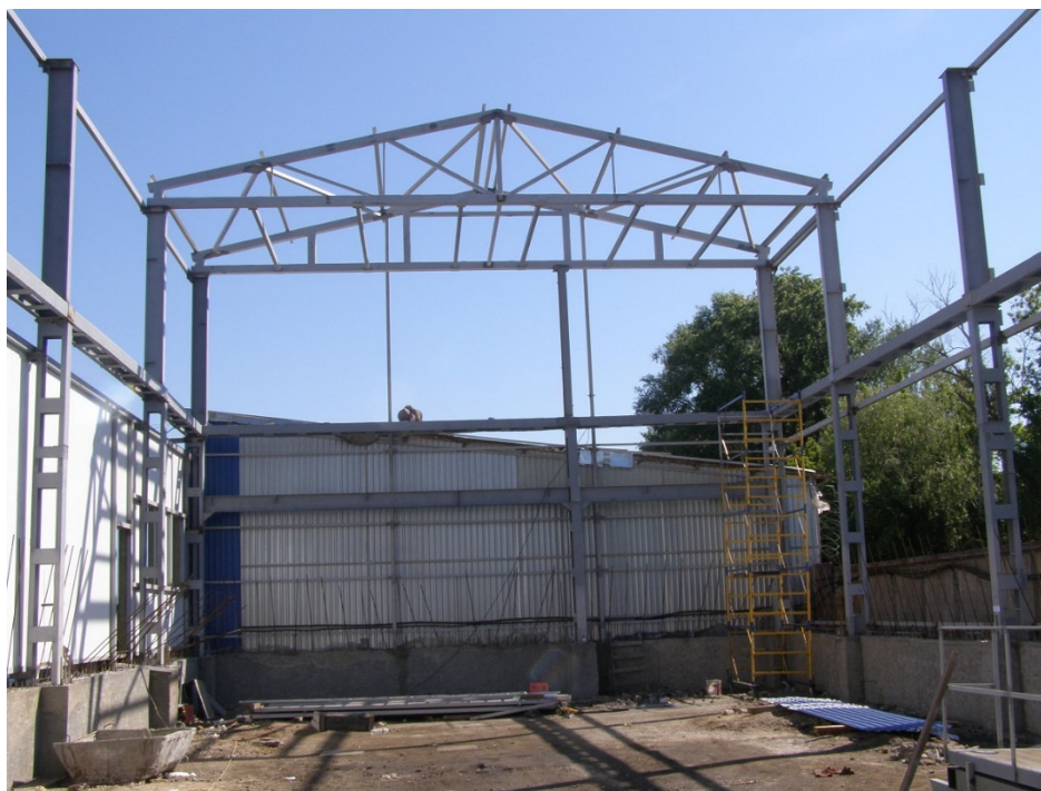
Рис. 5 – Вигляд конструкцій будівлі під час монтажу конструкцій покриття
