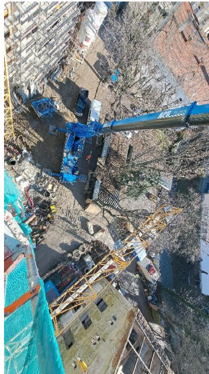
Рис. 2. Обмежений простір будівельного майданчика для демонтажу кранових конструкцій
