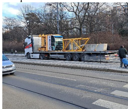
Рис. 6. Вивезення з будівельного майданчика металоконструкцій баштового крана в зоні міського руху
