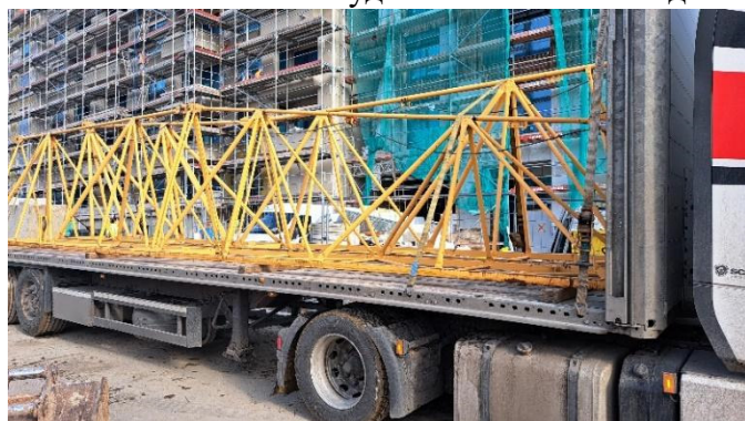
Рис. 5. Розміщення частини конструкції стріли баштового крана на вантажівці
