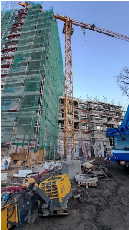
Рис. 1. Розташування баштового крана в комплексі будівельного майданчика
