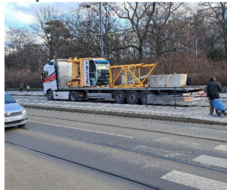
Рис. 6. Вивезення з будівельного майданчика металоконструкцій баштового крана в зоні міського руху
