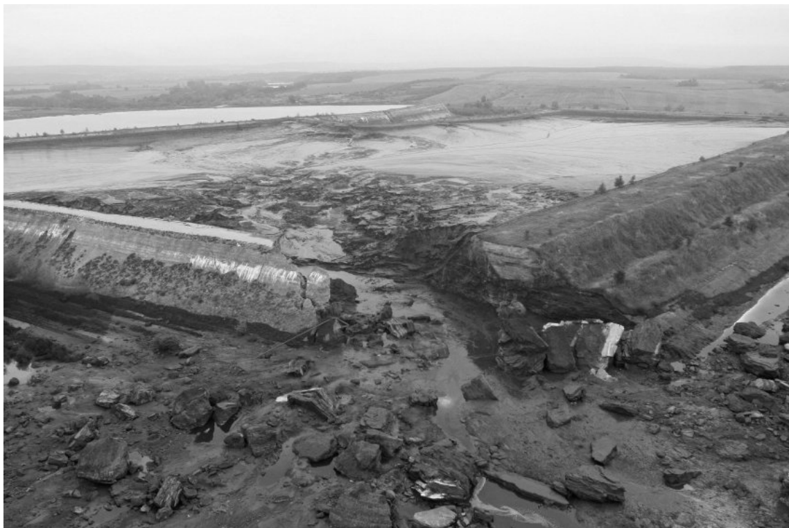
Рис. 3. Руїнування дамби хвостосховищ Ajkai Timfoldgyar Zrt 4 жовтня 2010 року
