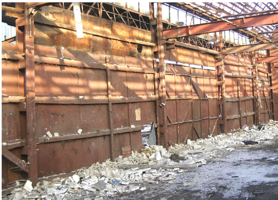
Рис. 2 – Загальний вигляд основних несучих конструкцій будівлі
