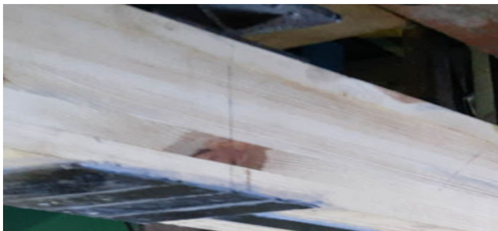
Рис.3. Кріплення (анкетування) країв композитної стрічки на дерев'яній балці
