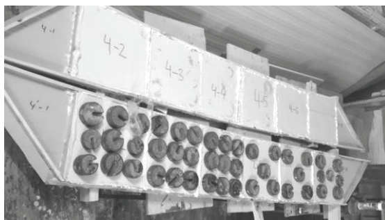
Рис.6 Процесс возведения панелей оболочки.
