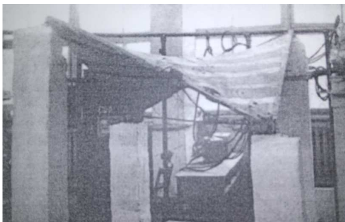
Рис. 3. Разрезка поверхности лепестка оболочки на сборные параболические элементы и Подъемистая оболочка из сборных элементов параболического профиля размером 1500х1500 мм. а) Восходящие параболы (ac); б) Нисходящие параболы (bd); в) Параболические элементы ( П-1)-(П-5); г) Стыки параболических элементов (1-1)-(4-4).
