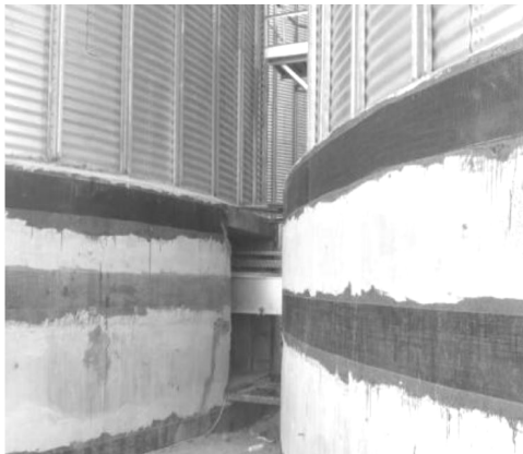
Рис. 8. Усиление железобетонных конструкций цилиндрической формы внешним углеволоконным фибропластиковым армированием: а — элементов башни Qafco Prill Tower , Катар [59], б — опор силосов, Российская федерация [61]
