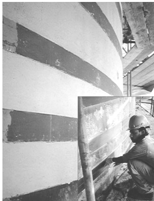
Рис. 8. Усиление железобетонных конструкций цилиндрической формы внешним углеволоконным фибропластиковым армированием: а — элементов башни Qafco Prill Tower , Катар [59], б — опор силосов, Российская федерация [61]
