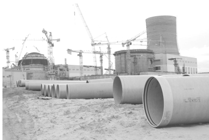
Рис. 10. Современные фибропластиковые цилиндрические оболочки: а — транспортировка вертикальных фибропластиковых резервуаров диаметром 14 м и высотой 17 м [71], б — стекловолоконные трубы диаметра 1200 мм и рабочего давления 10 атм. на Нововоронежской АЭС-2 [72], в — мобильный фибропластиковый резервуар, армированный углеволокном, предназначенный для хранения под высоким давлением сжиженного водорода [73]
