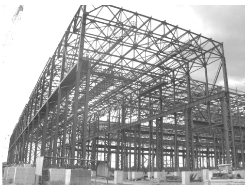
Рис. 1. Стальной каркас промышленного здания
