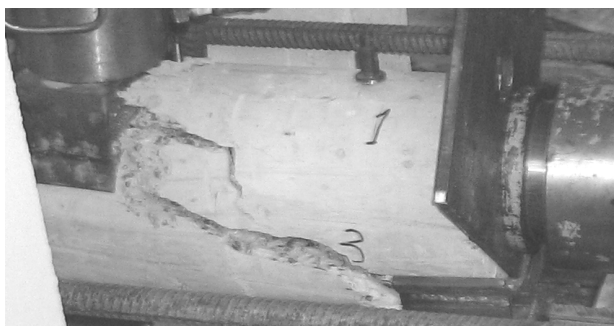
Рис. 4. Разрушение колонны с предварительным обжатием по наклонному сечению.
