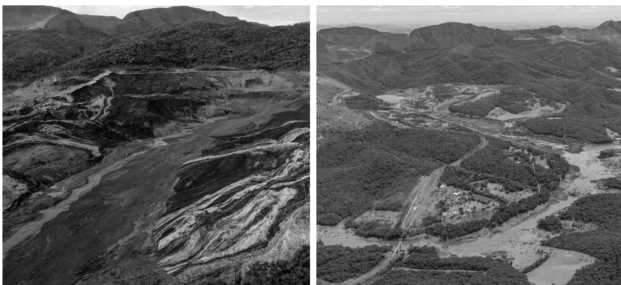
Рис. 2. Аварія на дамбі хвостосховища Corrego de Feijão в Брумадіньо 25 січня 2019 року
